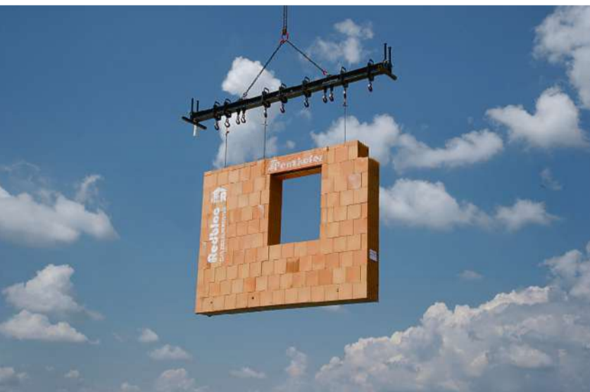
Die fliegenden Wände: Mit Hilfe eines Krans gelangen die fertigen Wände auf der Baustelle aus der Luft an ihren Platz.
