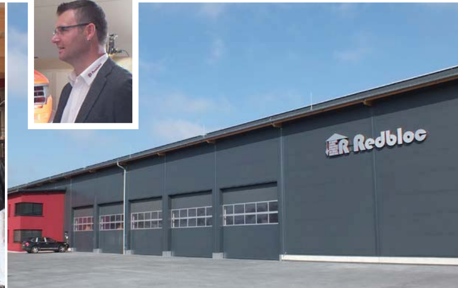
Wie Geschäftsführer Alexander Penzkofer (oben) bei der Besichtigung betonte, habe er rund fünf Millionen Euro in sein neues Werk auf einem 30.000 Quadratmeter großen Areal in Plattling investiert
