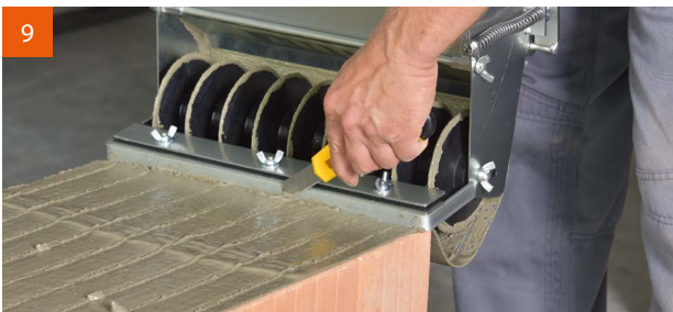
9 Abschneiden des V.Plus®-Glasfilamentgewebes mit Hilfe der Abschnittleiste und einem Teppichmesser.
