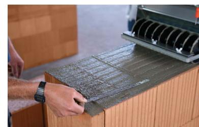
Ggf. zusätzliche Lagesicherung mit Flachstahllanker.
