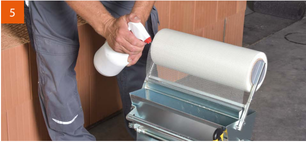
5 Die V.Plus®-Walze vor dem Befüllen mit Trennmittel (Schalöl) einsprühen. Das erleichtert die spätere Reinigung.
