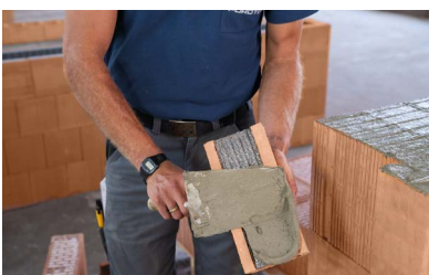
Anmörteln der Anschlagsschale.
