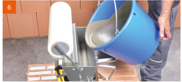
6 Befüllen der V.Plus®-Walze mit Dünnbettmörtel.
