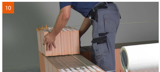
10 Einfaches knirsches Versetzen des Planziegels.
