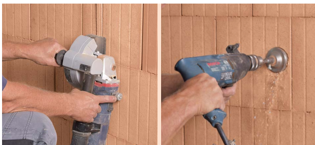
Schlitz und Kronenbohrung für Elektroboxen
