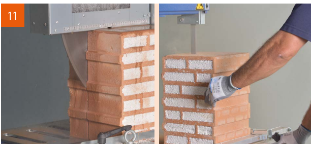
11 Ausgleichsziegel mit der Nass- oder Trockensäge schneiden.
